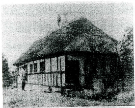
Helnæs byvej 33 Skole fra 1660- 1852 Derefter sognets fattighus.
