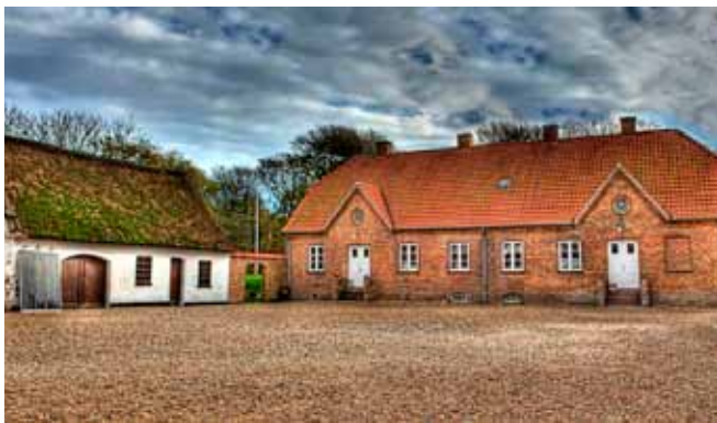
Vedersø Præstegård før restaurering 2011
