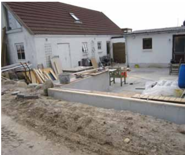
Helnæs Camping under ombygning
